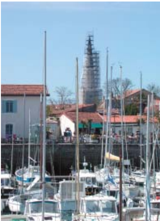
L'échafaudage de la flèche devrait disparaître d'ici la saison.
