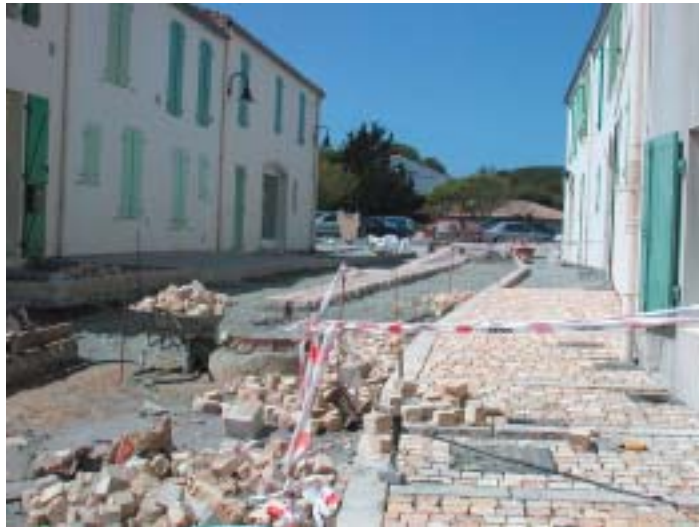
Le chantier de la rue du Vieux-Puits.
