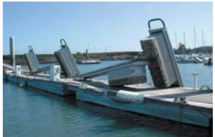
Les pontons démantibulés par la vague qui a déferlé dans le bassin.
